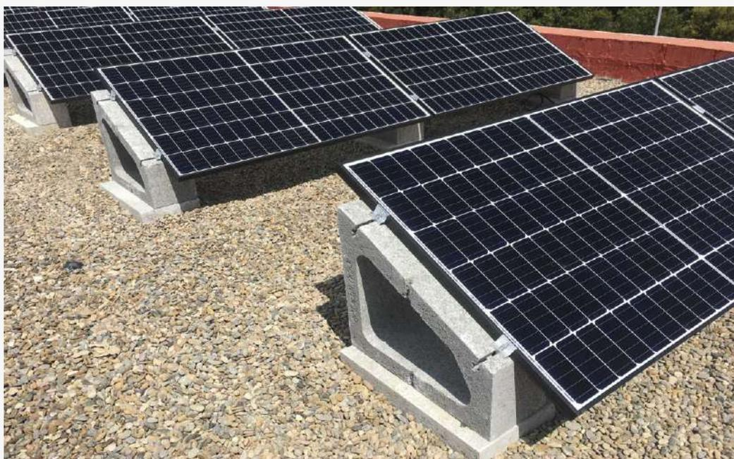
El sistema Solarbloc® permite fijar los módulos solares directamente al soporte sin utilizar estructura metálica. **Los soportes Solarbloc® se fabrican en nueve grados distintos, 0°, 3°, 10°, 12°, 15°, 18°, 28°, 30° y 34°.** Debemos elegir la inclinación del soporte más idónea teniendo en cuenta las necesidades de la instalación.
