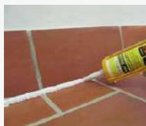
**Como junta flexible**, después de diseñar la junta y preparar la superficie, extrusionar cuidadosamente sin crear burbujas de aire y presionar la masilla contra los vértices de la junta. Se recomienda delimitar la junta con cinta de enmascarar. Eliminar la cinta antes de que la masilla comience a polimerizar.
