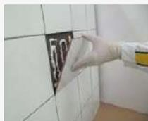
**Como adhesivo**, aplicar **weber flex PU** en superficie por cordones o por puntos. Fijar la pieza a pegar antes de que la masilla forme piel, ejerciendo una simple presión. Si fuera necesario mantener la presión durante la polimerización.
